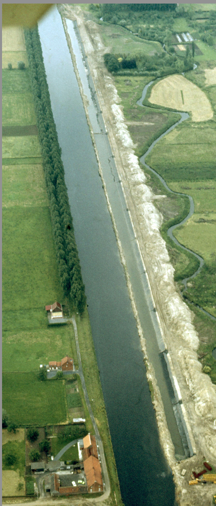
Werken aan het Schipdonkkanaal in Landegem tussen Landegembrug en de spoorwegbrug
